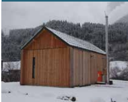
Chauffe-bois, réseau de chaleur de la commune de Saint-Jeoire
