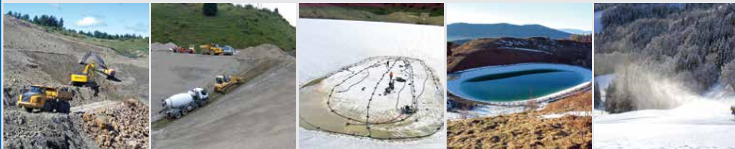
Réalisation de la retenue collinaire
