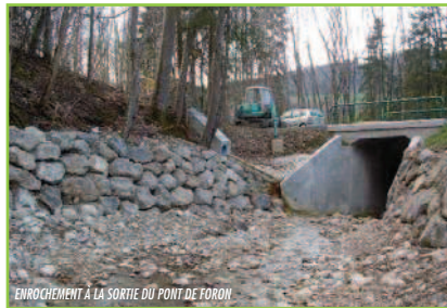
ENROCHEMENT A LA SORTIE DU PONT DE FORON
