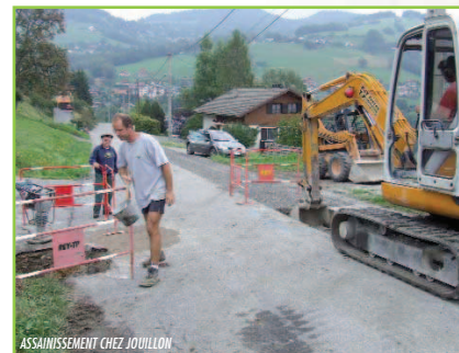
ASSAINISSEMENT CHEZ JOUILLON
