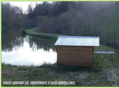
CHALET ABRITANT LES EQUIPEMENTS D'AUTO-SURVEILLANCE
