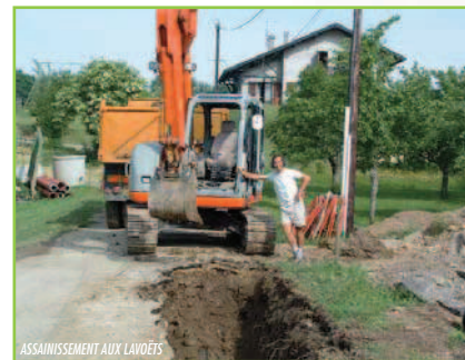
ASSAINISSEMENT AUX LAVOIRS
