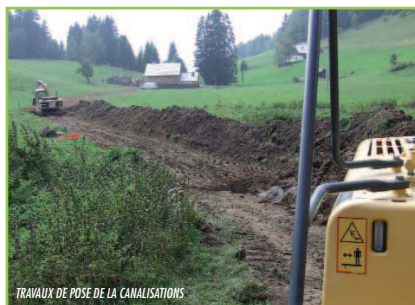
TRAVAUX DE POSE DE LA CANALISATION
