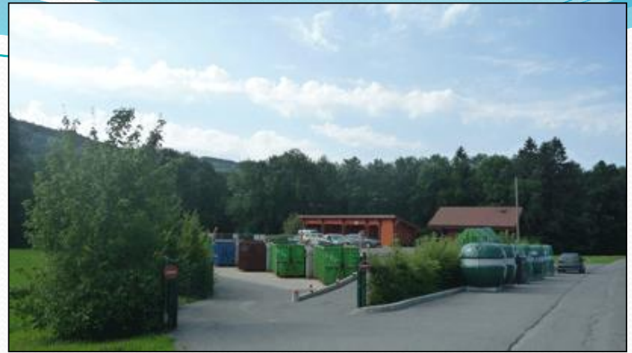
Déchetterie intercommunale (source: CCVV)
