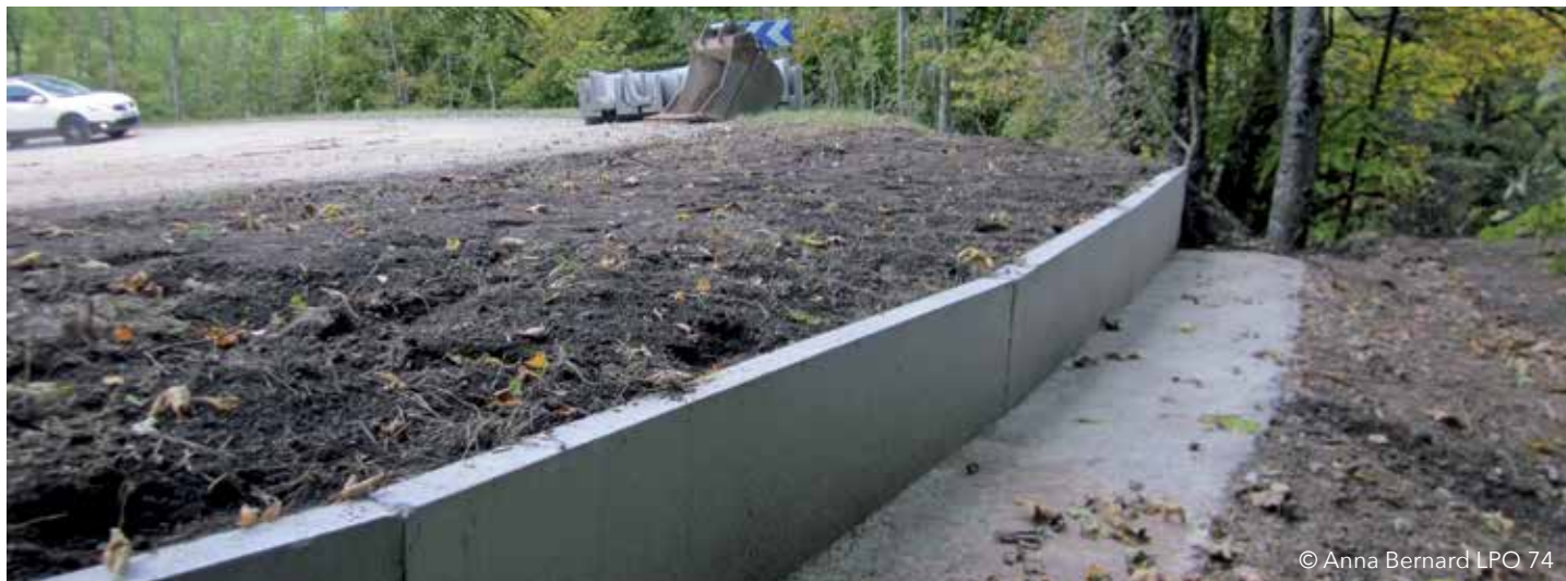
Paroi de guidage en construction
