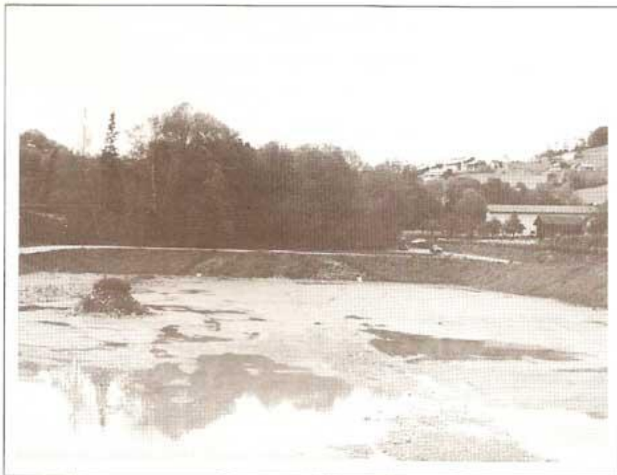
Bassin de lagunage.
