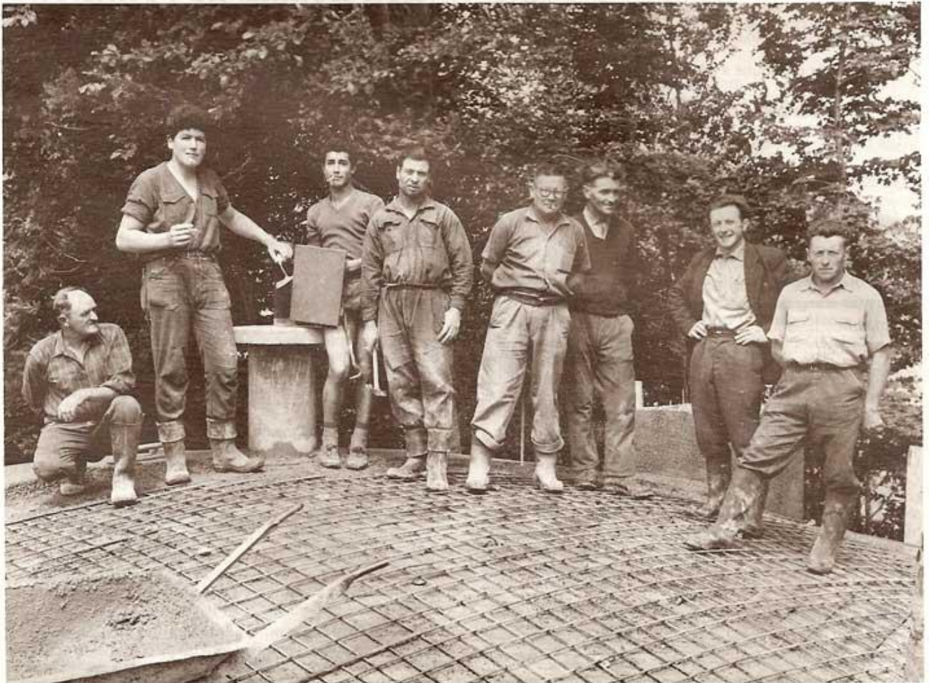
Quelques « Bogévans » et les ouvriers de l'entreprise Vaglio sur notre premier réservoir d'eau potable. « Le Clos Michaud », été 1960.
